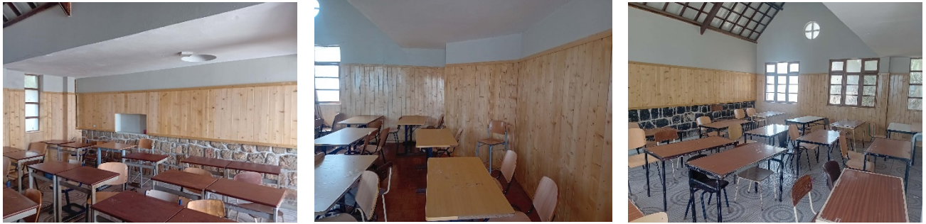
Figure 9 Imagens do revestimento das paredes das salas do Bloco I com madeira
