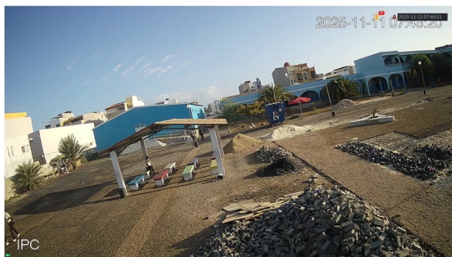
Figure 20 Registo fotográfico de calçamento após remoção de pavês.
