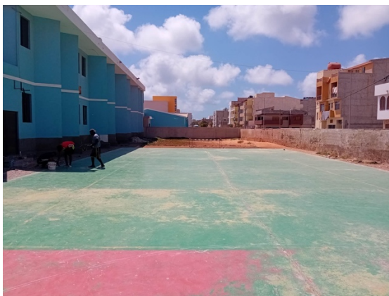
Figure 14 Campo Aberto de Educação Física ESBV antes do alinhamento
