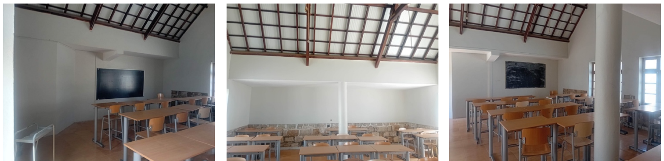
Figure 10 Pintura das salas do Bloco I
